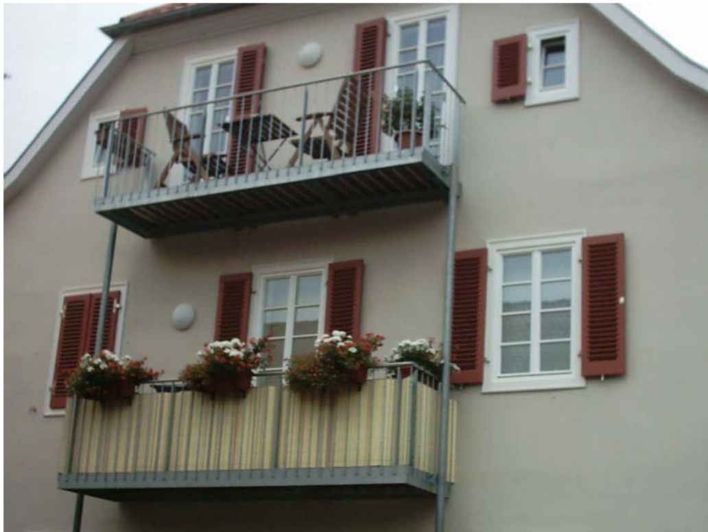
Alte Propstei in Coburg Neu- und Altbau mit M60-Fenstern
